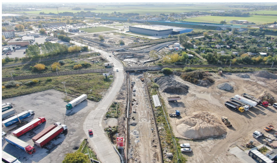
Budowa układu drogowego na ul. Działkowców.
