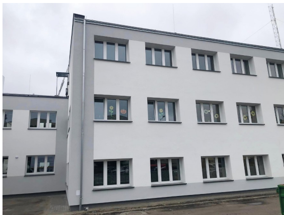
Modernizacja energetyczna budynku przy ul. Batorego.
