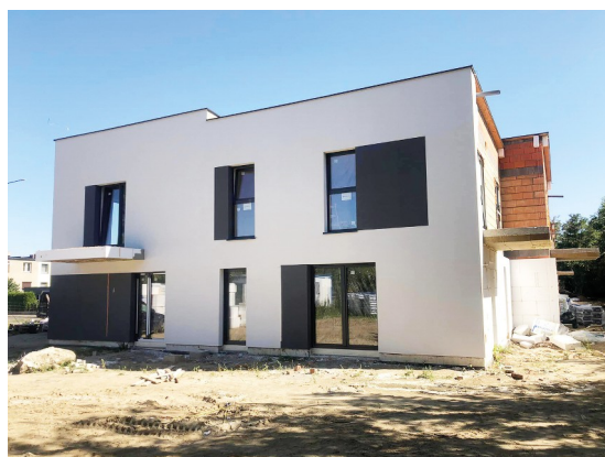
Budowa bloku wielorodzinnego przy ul. Pilskiej.
