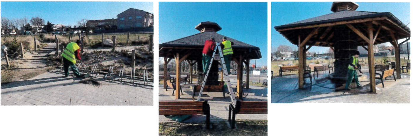
Prace porządkowe wykonywane na terenie tężni solankowej.
