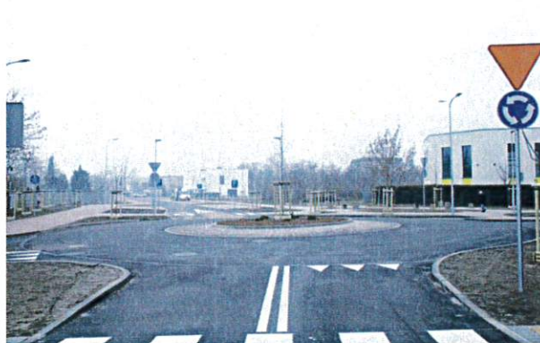
Zrealizowana inwestycja pn.: „Budowa, przebudowa ul. 68 Pułku Piechoty oraz przebudowa skrzyżowania na ul. 68 Pułku Piechoty, Zamysłowskiego i Kutrzeby we Wrześni”.
