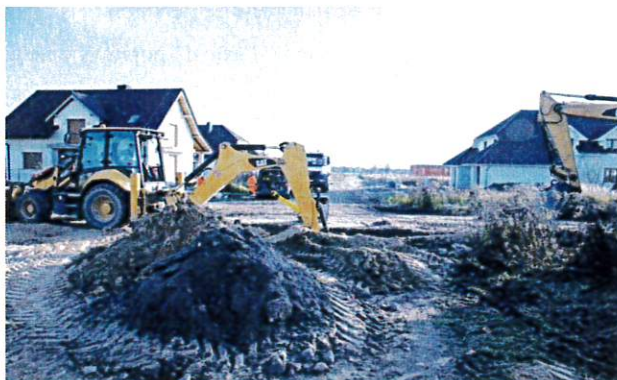
Trwające prace budowlane w Bierzgliunku związane z budową kanalizacji sanitarnej.
