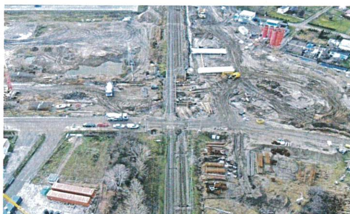
Budowa układu drogowego na ul. Działkowców.
