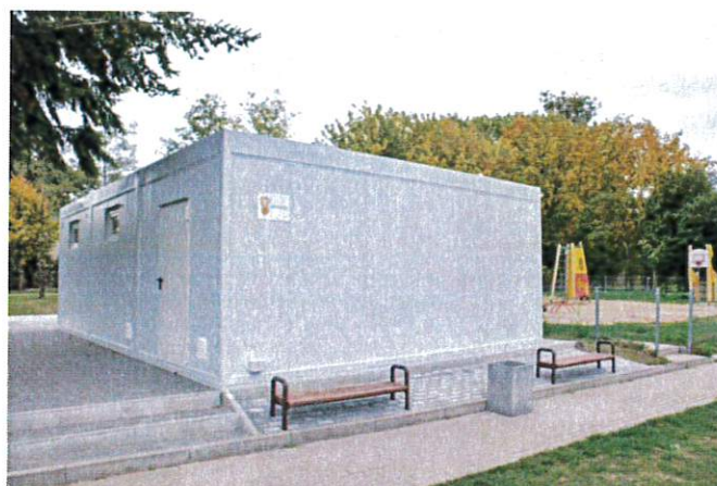
Zaplecze szatniowo-sanitarne w Bardzie.
