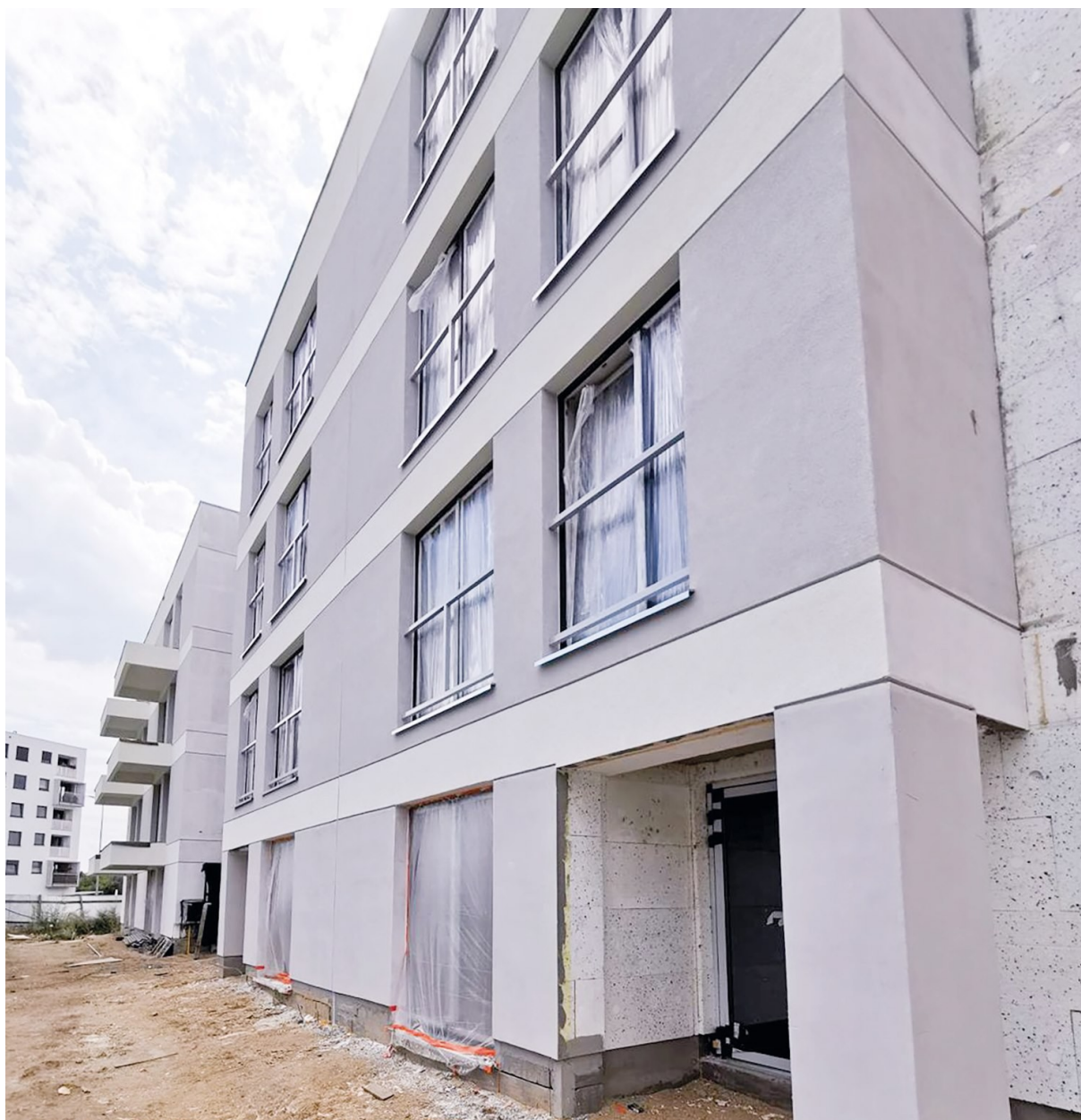
Fot. 1. Nowe mieszkania przy ul. B. Śmidowicz wybudowane w programie Mieszkanie Plus
