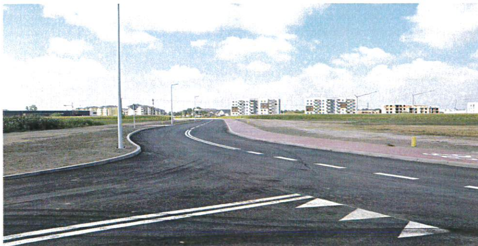
Nowa droga łącząca ulicę Słowackiego z ulicą Szosa Witkowska
