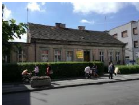
Zdjęcie 23 Zdegradowana zabytkowa kamienica w centrum Wrześni.
