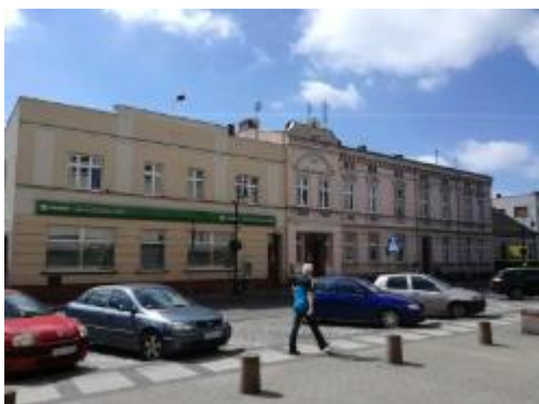
Zdjęcie 22 Zdegradowana zabytkowa kamienica w centrum Wrześni.
