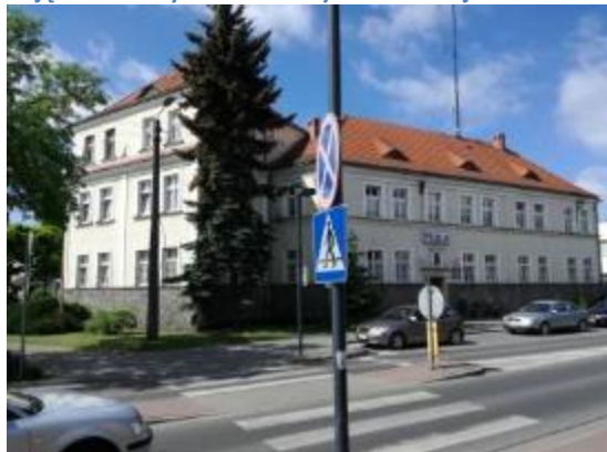
Zdjęcie 14 Budynek Komendy Powiatowej we Wrześni
