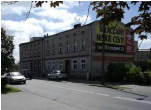
Zdjęcie 16 Zdegradowane budynki mieszkalne na obszarze rewitalizacji.
