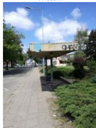
Zdjęcie 66 Zdegradowany przystanek autobusowy we Wrześni.
