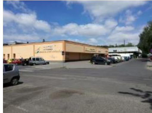
Zdjęcie 41 Przykład zabudowy usługowo-handlowej na terenie osiedla wielorodzinnego we Wrześni. Ulica Chrobrego, Osiedle 1000-lecia.
