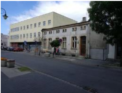
Zdjęcie 18 Zdegradowany zabytkowy budynek w sąsiedztwie Urzędu Skarbowego przy ul. Warszawskiej we Wrześni.
