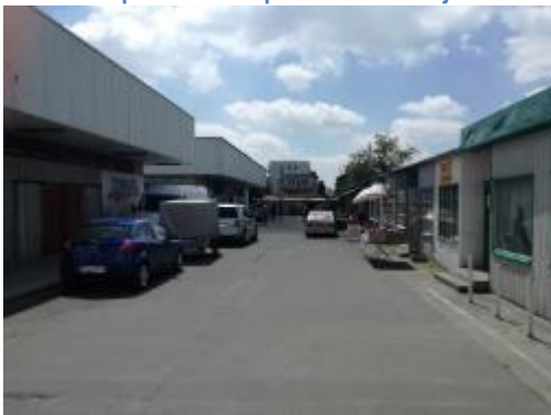
Zdjęcie 44 Osiedlowy obiekt handlowo-usługowy. Przykład zdegradowanej zabudowy, która stopniowo traci pierwotne funkcje.
