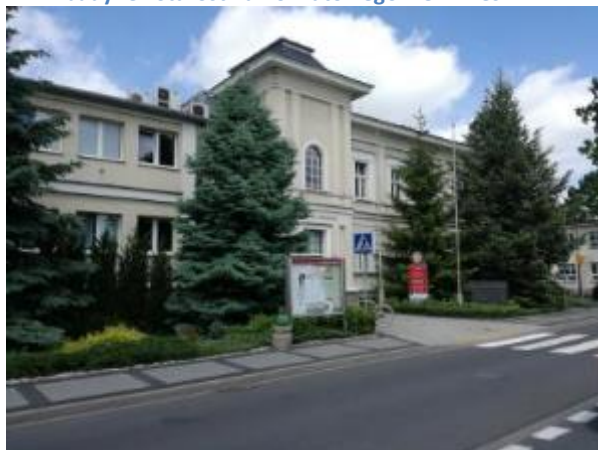
Zdjęcie 33 Zadbany, wyremontowany zabytkowy budynek Starostwa Powiatowego we Wrześni.
