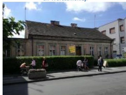
Zdjęcie 21 Zdegradowany zabytkowy dom mieszkalny przy ul. Warszawskiej.
