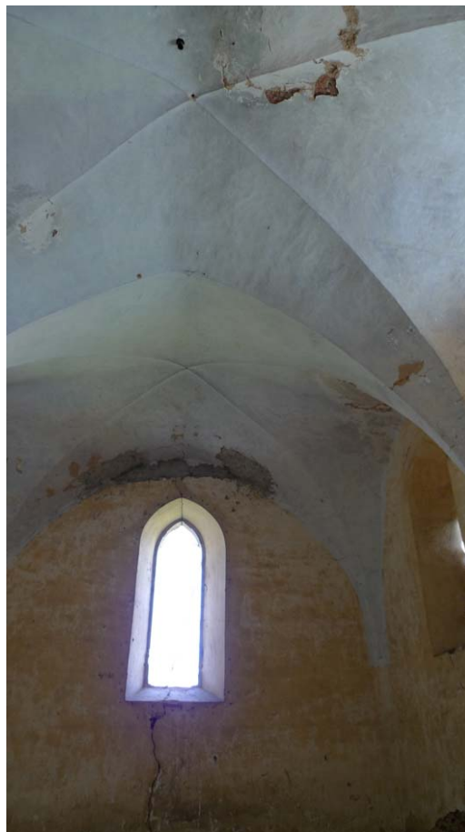
fot.10 Sklepienie prezbiterium
