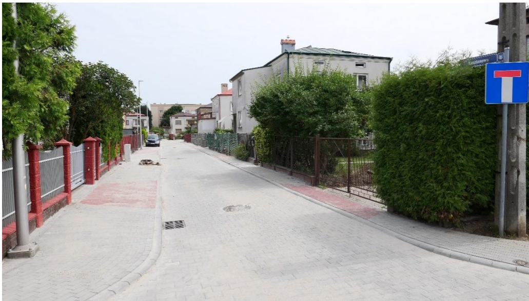
Fot. 13. Ul. Kasztanowa
