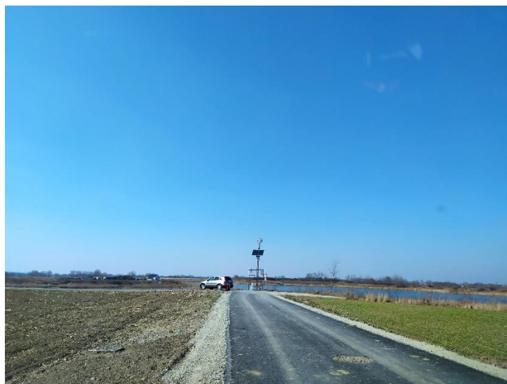
Fot. 24. Ulica Piaskowa po wykonaniu prac.
