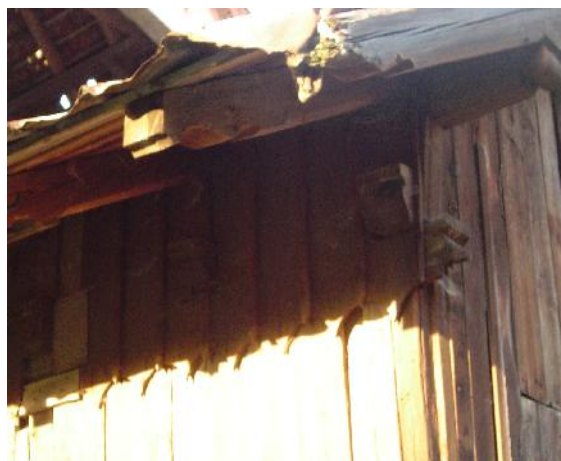
Elementy drewniane – szczyt budynku i deskowanie ścian
