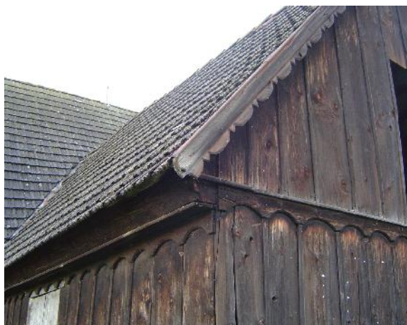
Elementy drewniane – szczyt budynku i deskowanie ścian
