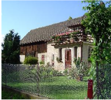
Częściej spotykane ogrodzenie z siatki metalowej
