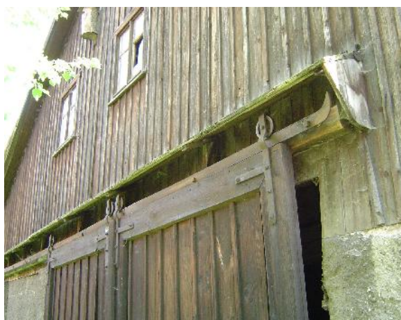
Elementy drewniane – brama i metalowe zawiasy
