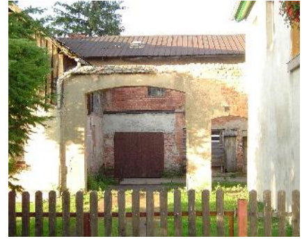
Brama wjazdowa z furtą
