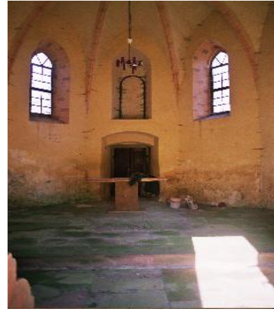
Wnętrze Kościoła p.w. Św. Stanisława Kostki
