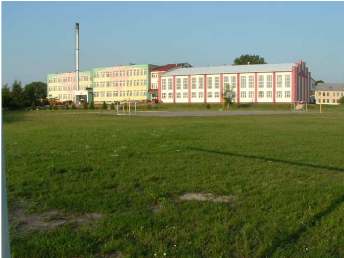
Zespół Placówek Oświatowych, Publiczne Gimnazjum Nr 1 oraz Sala Gimnastyczna w Piszczacu
