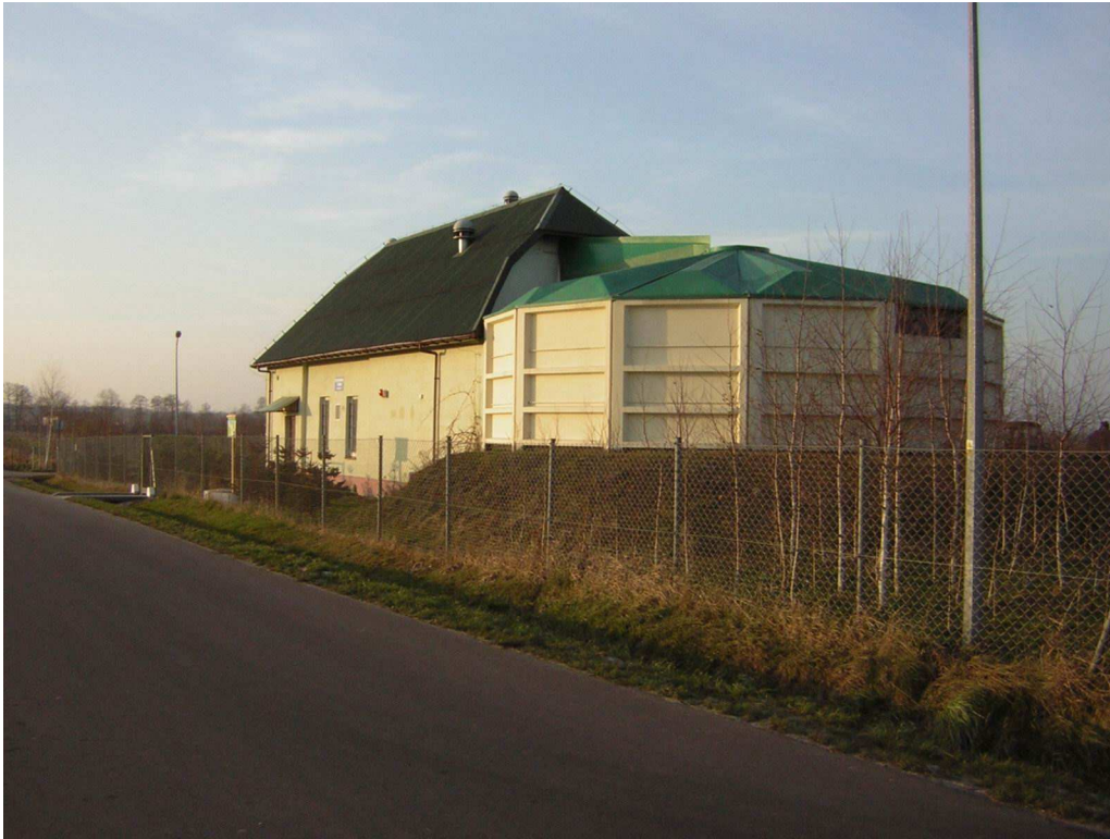
Oczyszczalnia ścieków w Piszczacu
