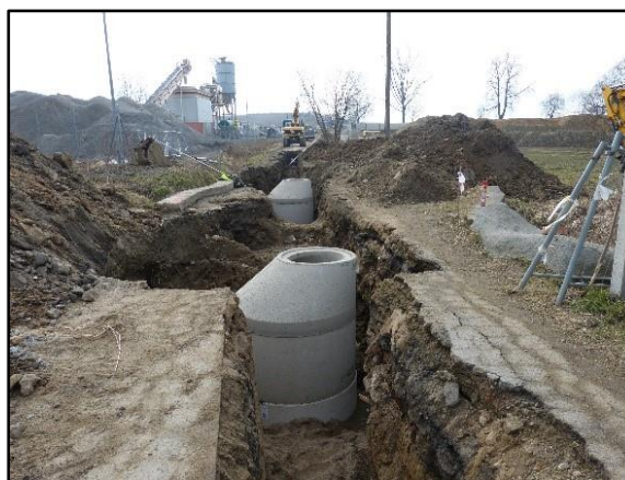
Budowa kanalizacji sanitarnej
