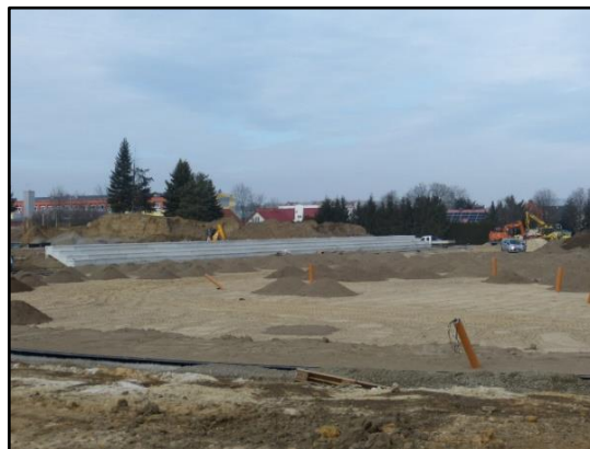
Stadion w trakcie przebudowy
