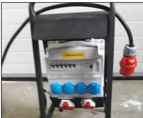
Rozdzielnica budowlana
