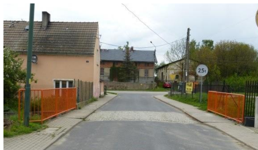
Nowe bariery mostowe przy ul. Jana Kilińskiego
