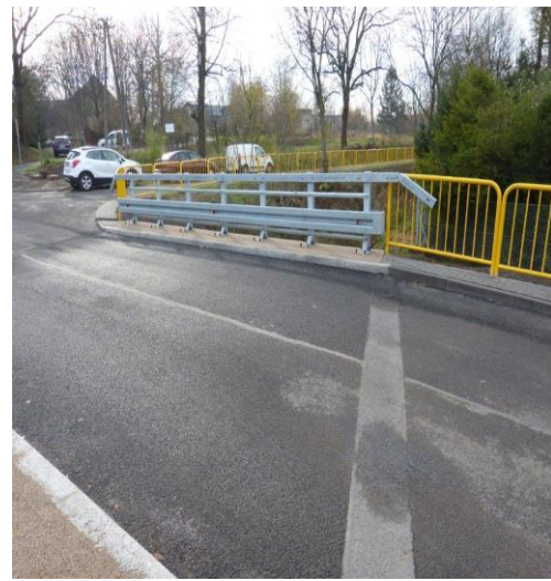
Przebudowa mostu drogowego ul. Henryka Sienkiewicza
