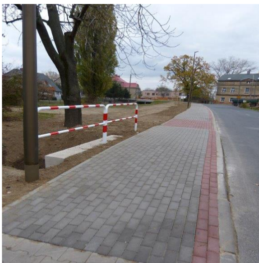
Budowa chodnika przy ul. Stawowej
