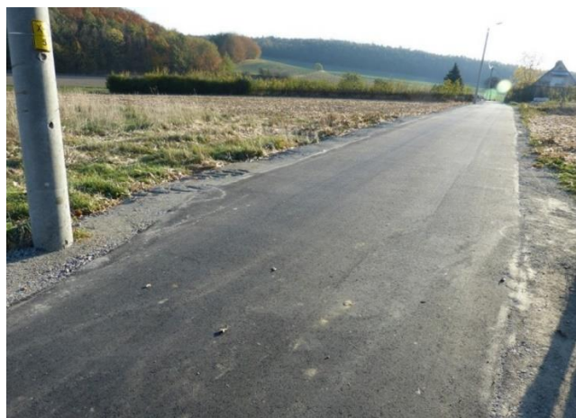
Przebudowa ul. Kosynierów
