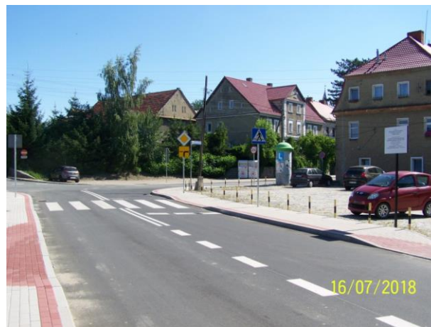
Remont ul. Fabryczna
