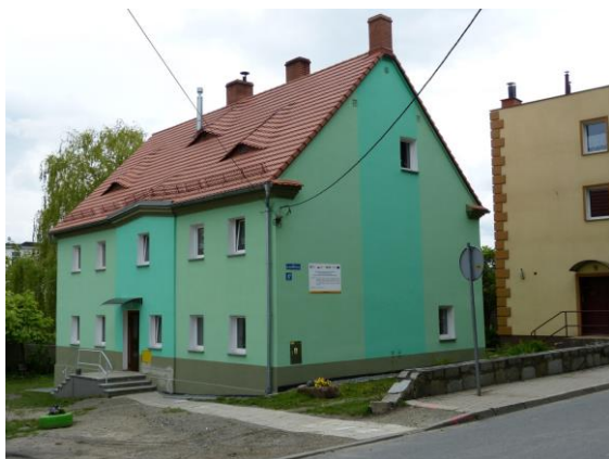
Remont elewacji ul. Sienkiewicza 17
