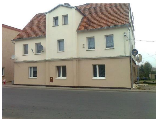
Remont elewacji ul. Piastowska 22
