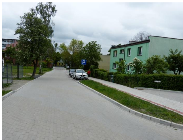
Remont ul. Adama Mickiewicza
