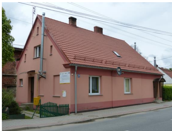
Remont elewacji ul. Sienkiewicza 20
