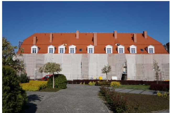
Budynek przy Placu Piastów Śląskich 4
