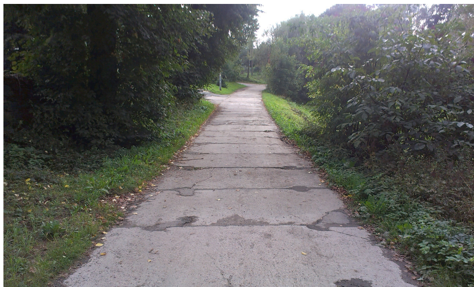
Odcinek środkowy z nawierzchnią z płyt betonowych.
