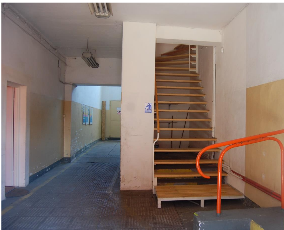
Pomieszczenie biurowe w lokalu nr 4
