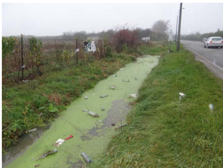
Ryc. 263. Zaśmiecenie rowów przydrożnych
