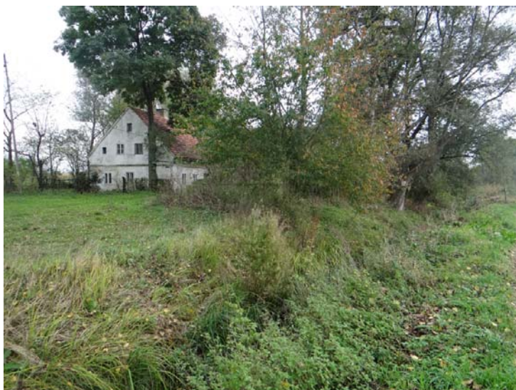
Ryc. 260. Zaniedbany rów melioracyjny - roślinność na skarpach i w rowie znacznie ogranicza jego przepustowość
