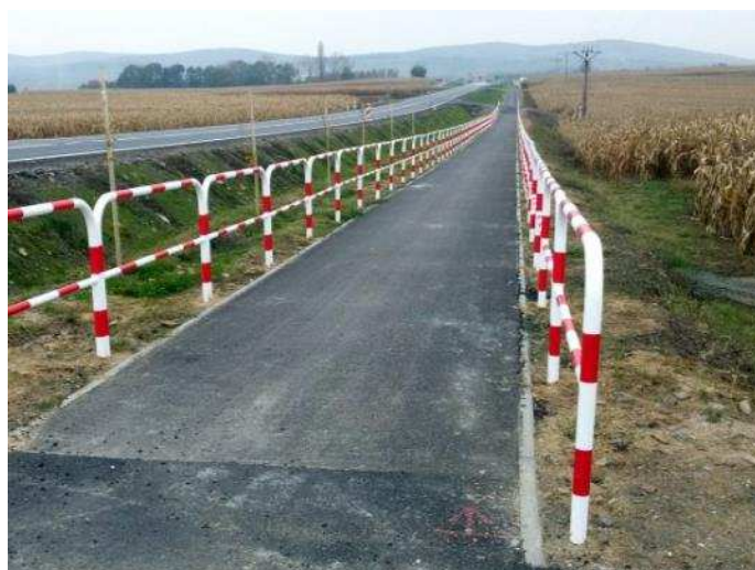
FOTOGRAFIA 6. NOWOPOWSTAŁA DROGA ROWEROWA PRZY DRODZE WOJEWÓDZKIEJ NR 384 NA TRASIE ŁAGIEWNIKI - SIENIAWKA
