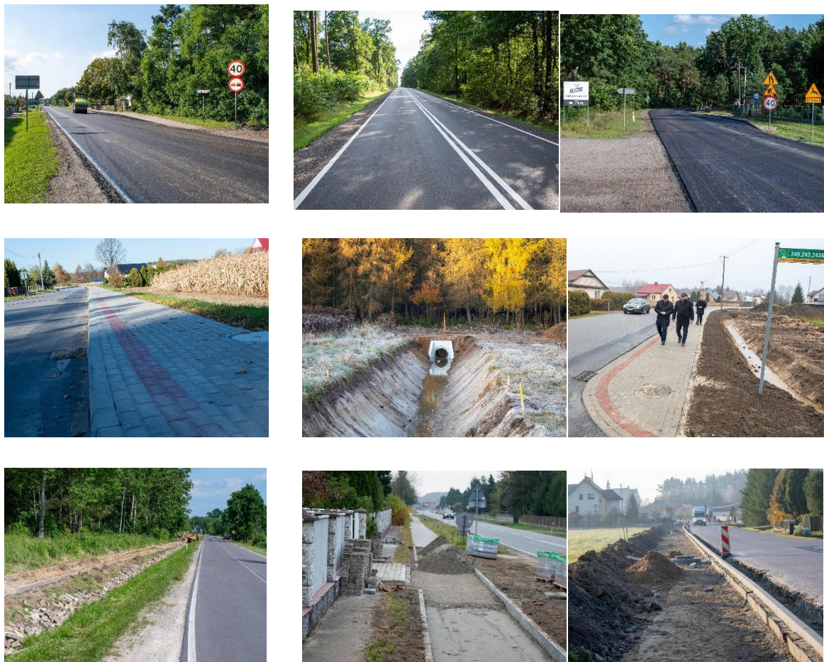
Zdjęcia: Przykładowe inwestycje drogowo-chodnikowe na terenie gminy Ostrów w 2021r.
