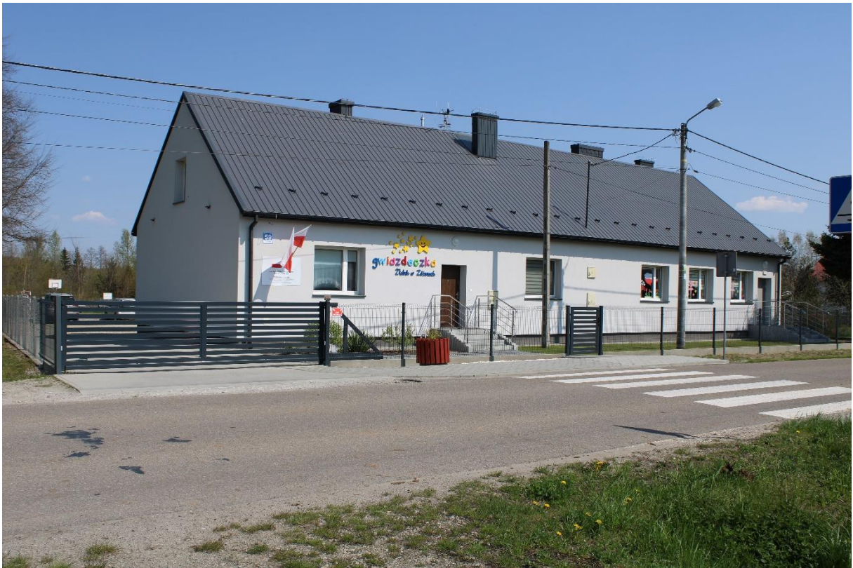
Zdjęcie: Ogrodzenie frontowe obiektu z furtką i automatyczną bramą przesuwaną
