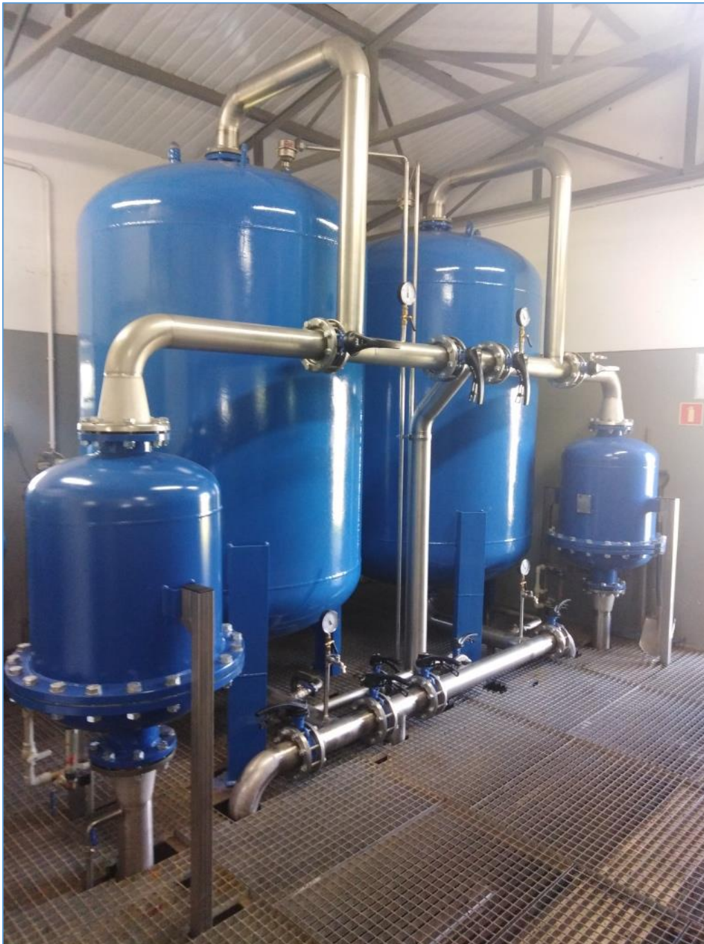
Zdjęcie: Hala technologiczna S.U.W. Wola Ociecka
