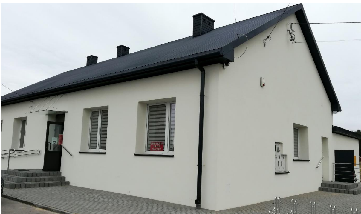
Zdjęcie: Budynek Biblioteki i NZOZ-u w Ociece po termomodernizacji.
