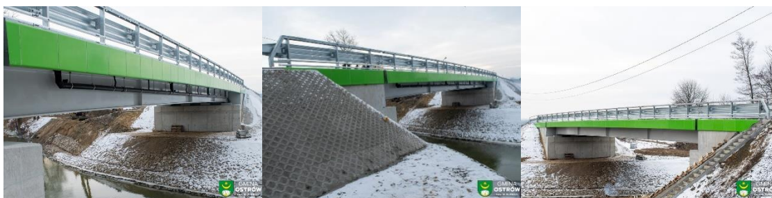
Zdjęcie: Zrealizowana inwestycja mostowa w miejscowości Kozodrza.
