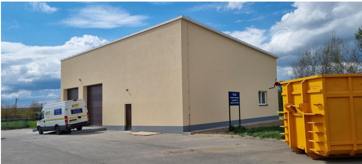
Zdjęcie: Budynek garażowo-warsztatowo-magazynowy
