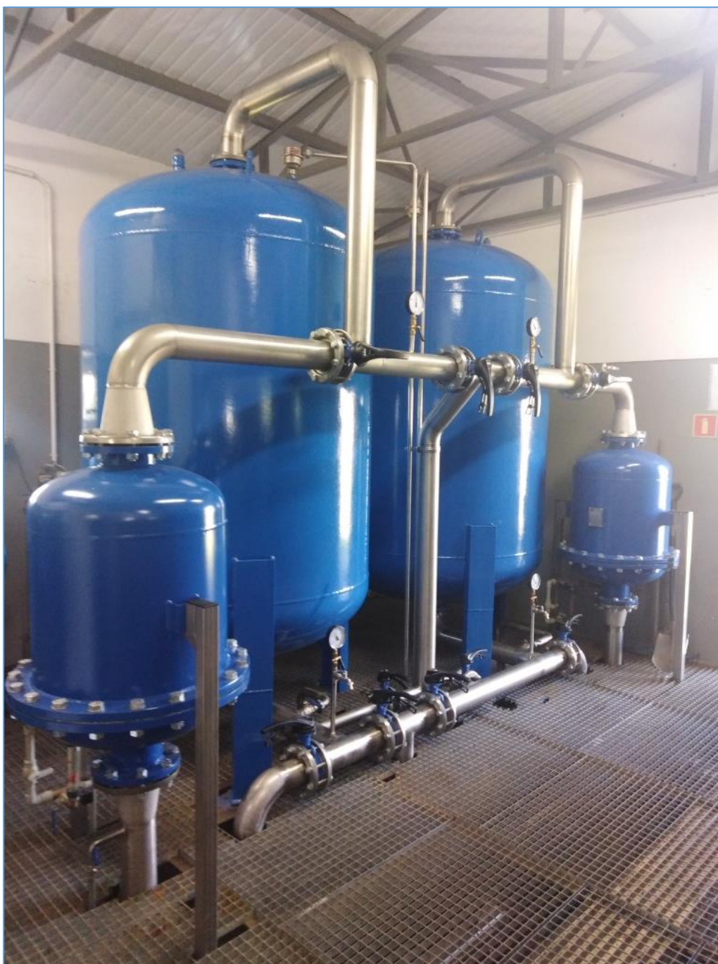
Zdjęcie: Hala technologiczna S.U.W. Wola Ociecka
