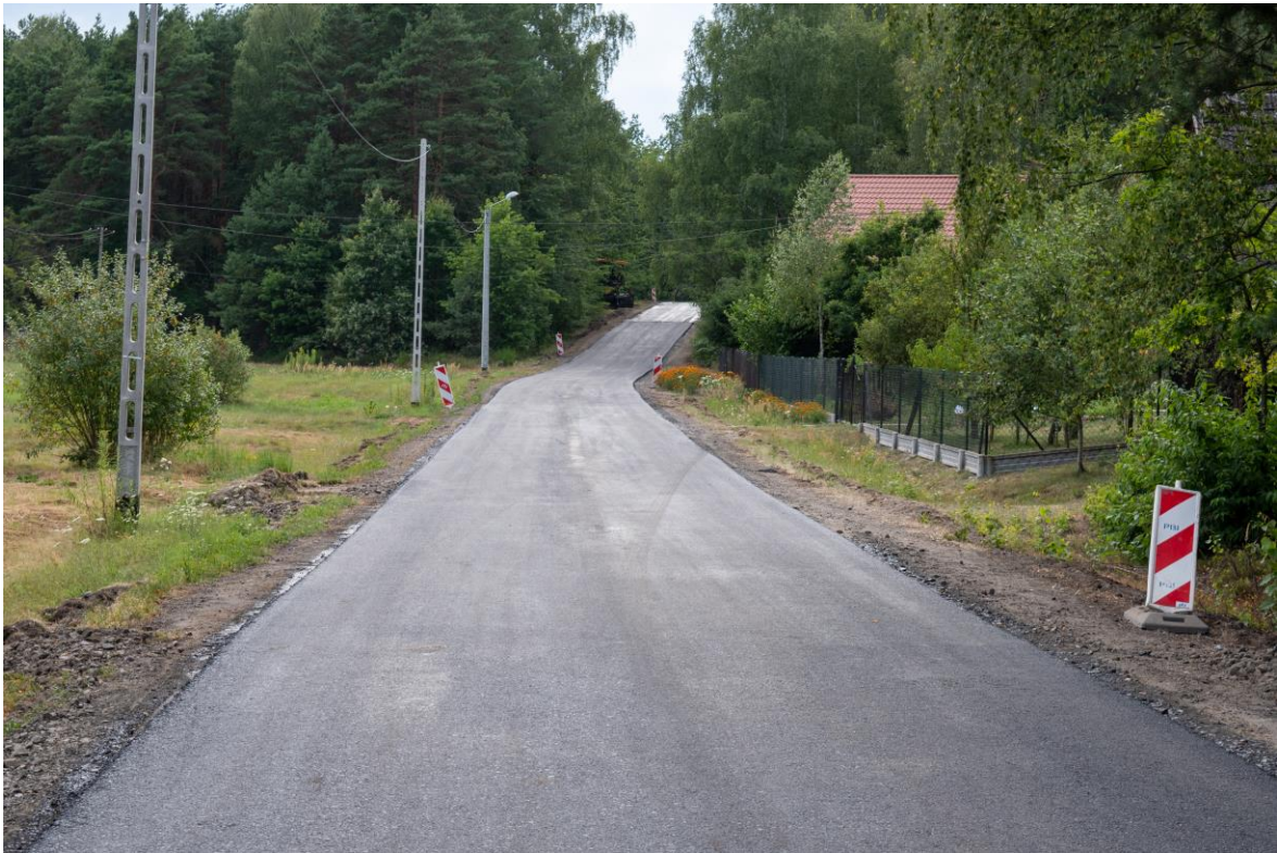
Zdjęcie: Remont drogi gminnej Nr 107452R Ocieka – Sadykierz
