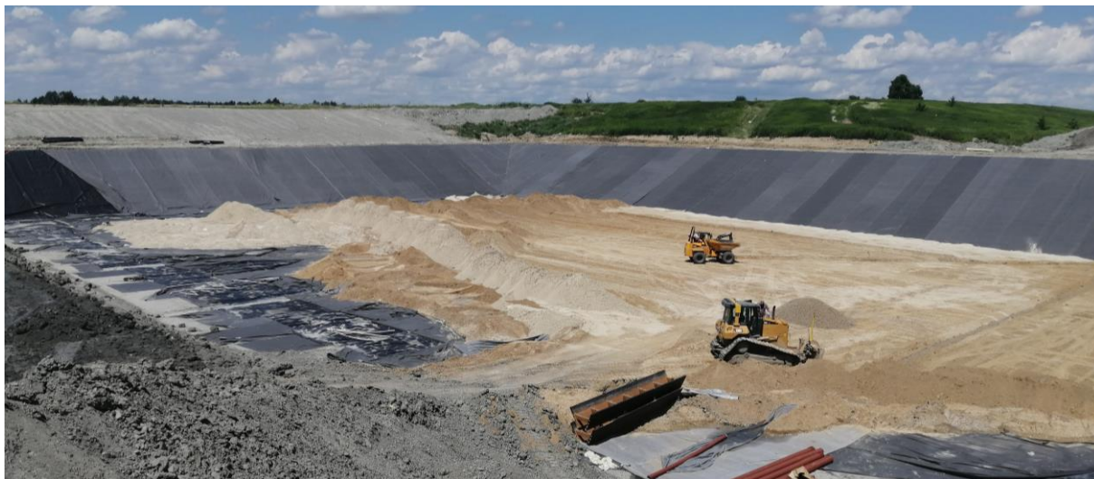
Zdjęcie: Budowa kwatery nr 13 sektor I i II
