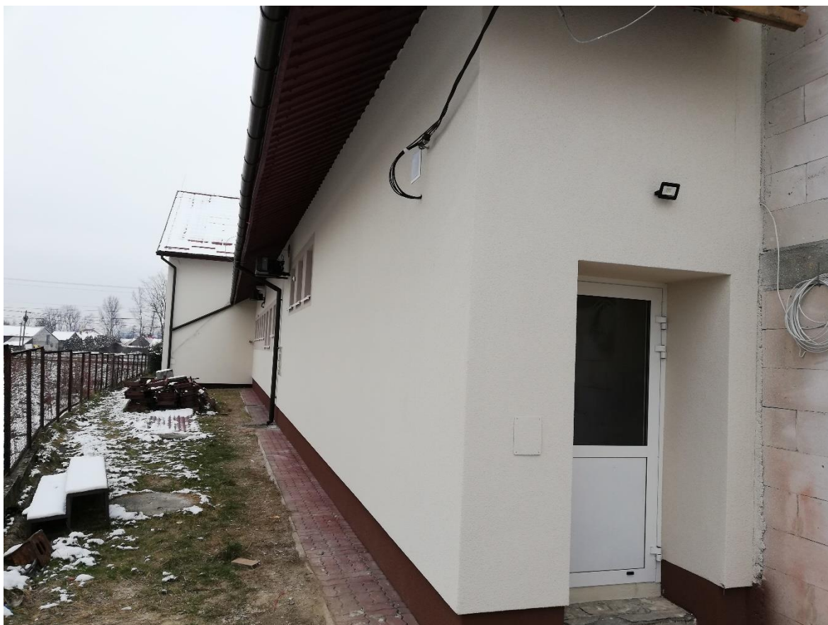
Zdjęcie: Termomodernizacja budynku OSP w Kozodrzy
