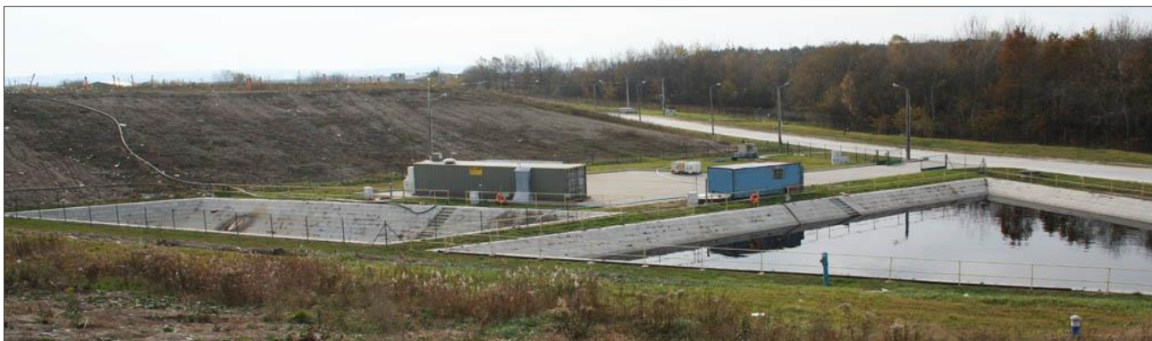
fot. Kontenerowa oczyszczalnia odcieków
