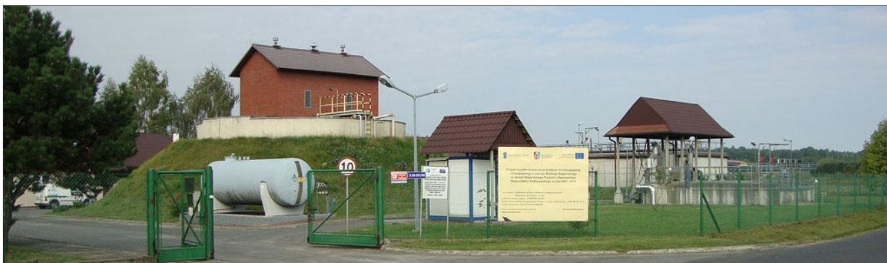
Fot. Oczyszczalnia ścieków w Skrzyszowie.
