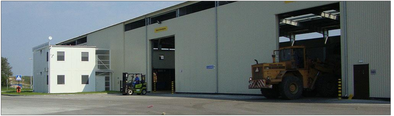
Fot. Zakład Zagospodarowania Odpadów w Kozodrzy.
