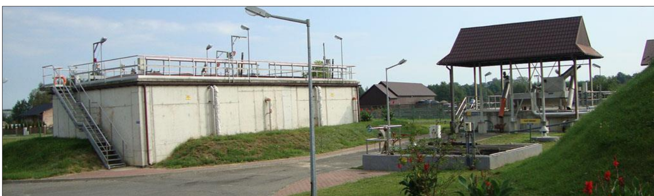
Fot. Oczyszczalnia ścieków w Skrzyszowie.
