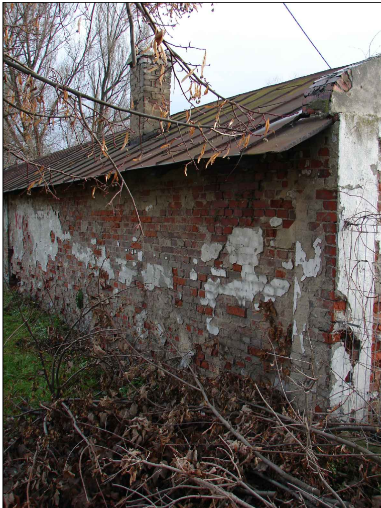
ŚCIANA PÓŁNOCNA CZĘŚCI MIESZKALNEJ
