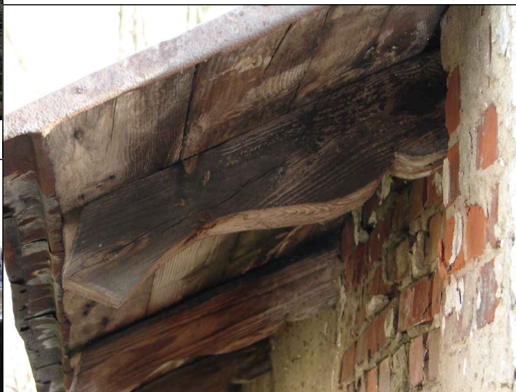
DETAL OKAPU CZĘŚCI MIESZKALNEJ
