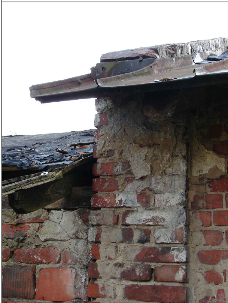
POKRYCIE DACHOWE BUDYNKU
