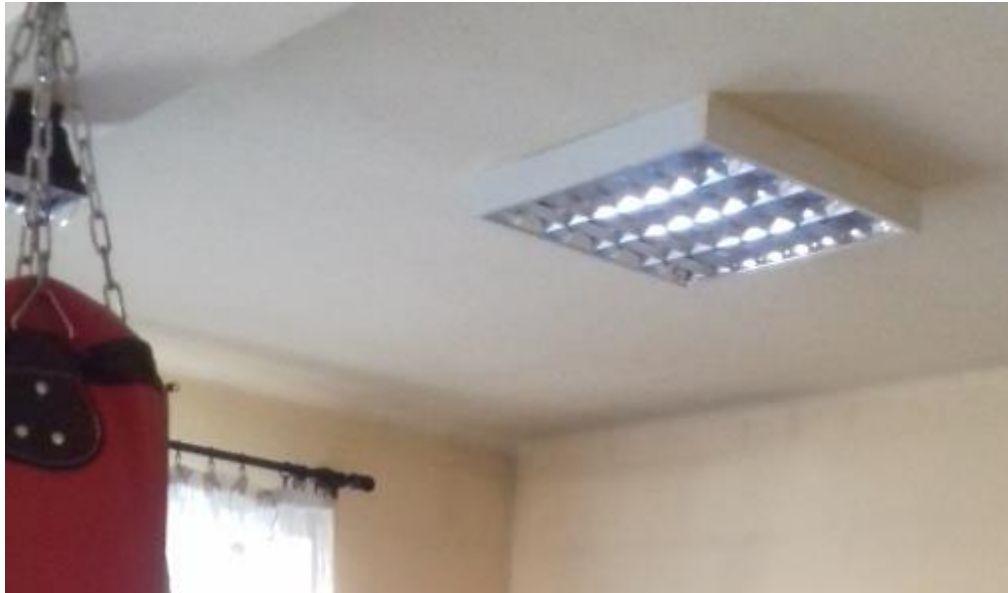
[Fot. 4 – Strop pomieszczeń]
