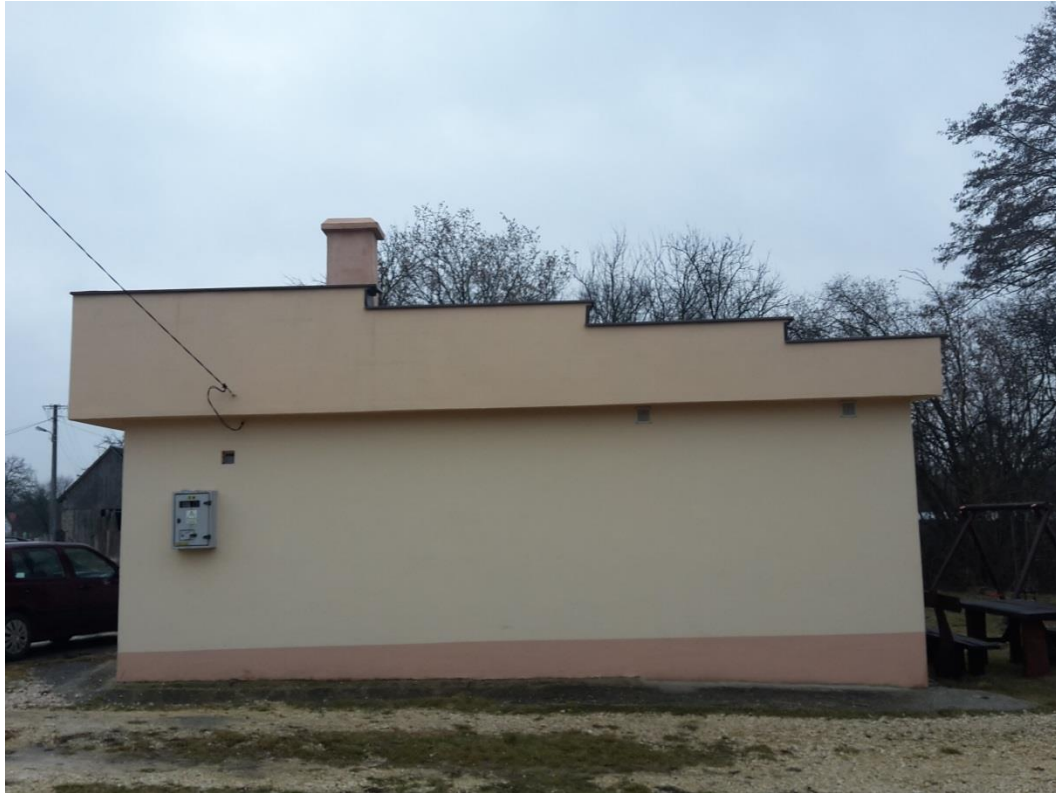
[Fot. 3 – Elewacja boczna - południowa]
