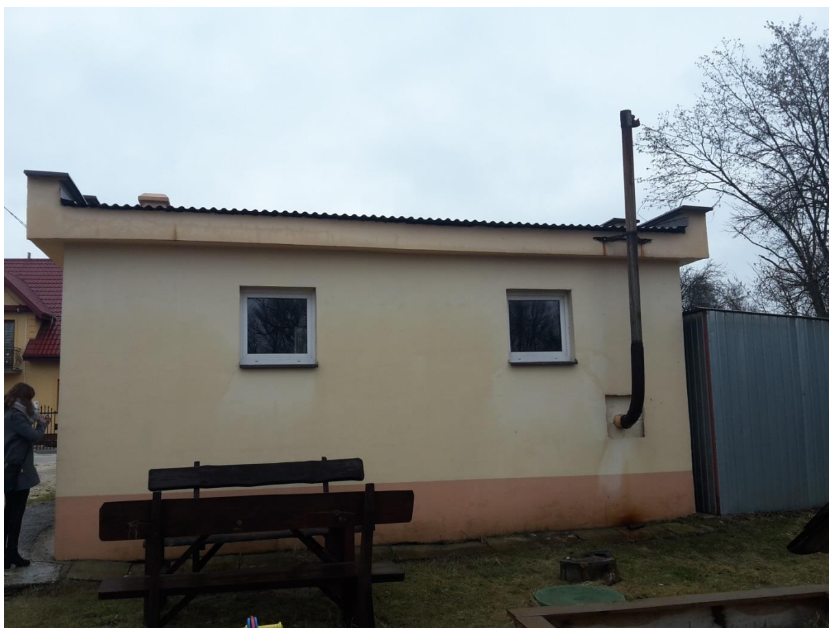
[Fot. 2 – Elewacja tylna]
