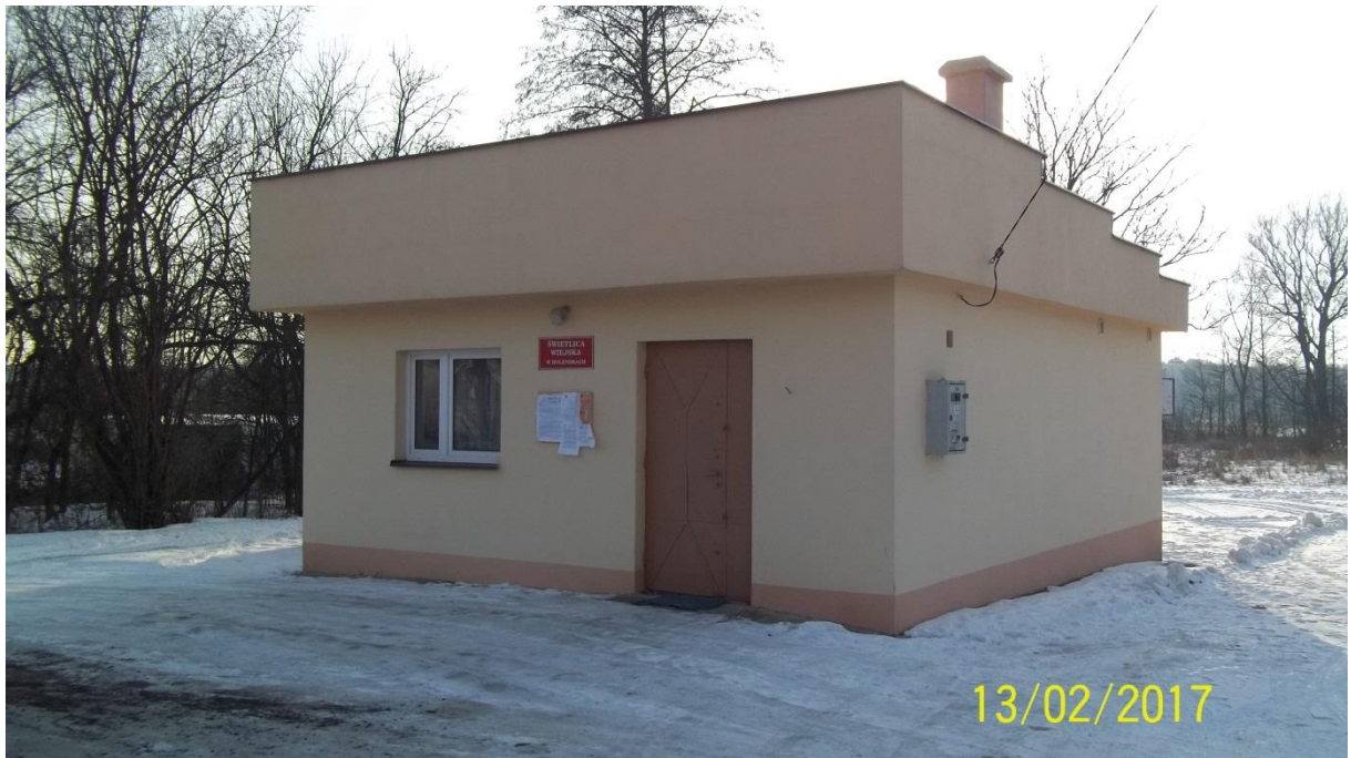
[Fot. 1 – Elewacja frontowa]
