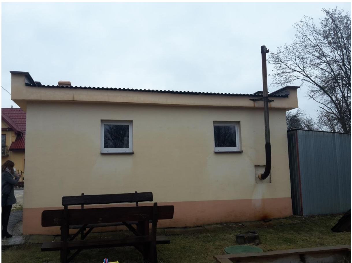
[Fot. 2 – Elewacja tylna]
