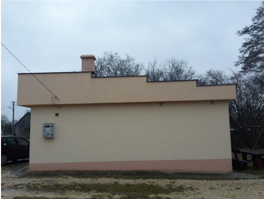
[Fot. 3 – Elewacja boczna - południowa]
