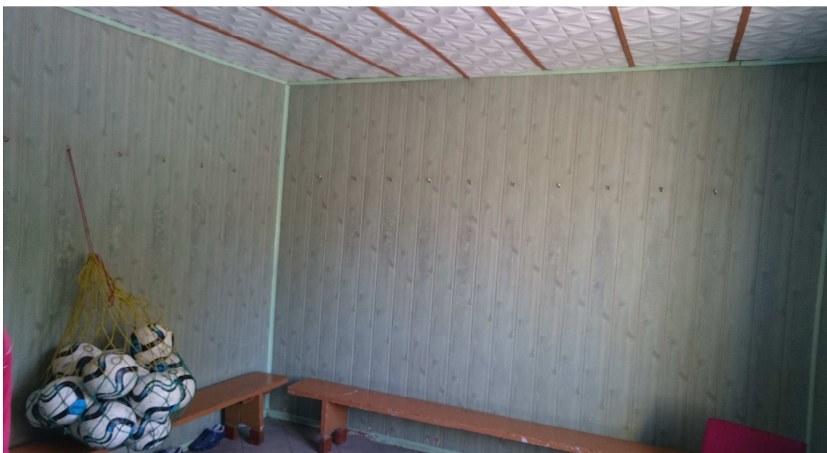
Ściany wewnątrz budynku wykończenie
