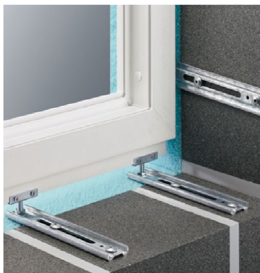
Rys. Montaż okna za pomocą kotew
