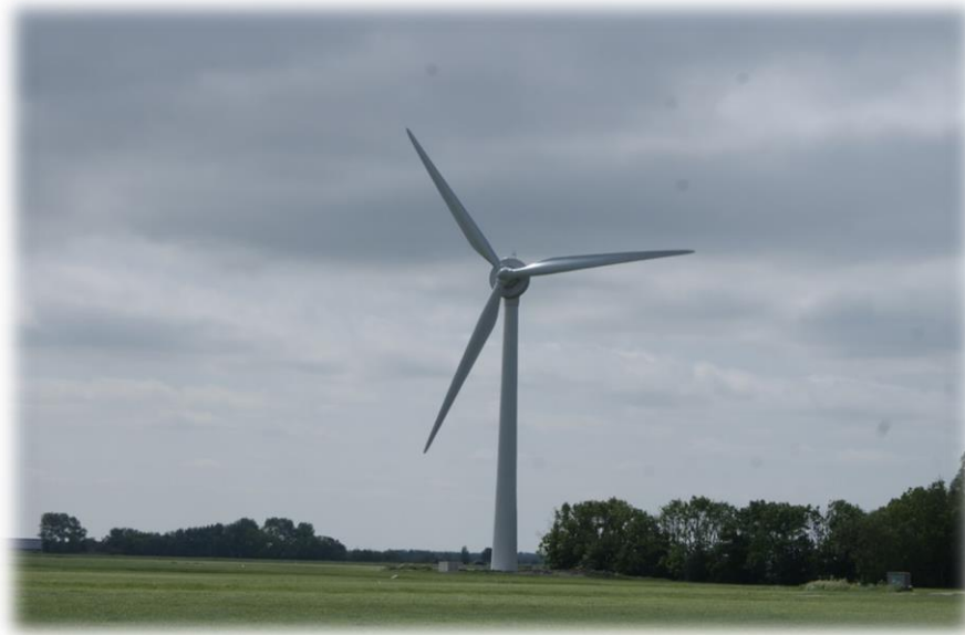
Rys. 26. Elektrownia wiatrowa Autor: Ryszard Wnuk
