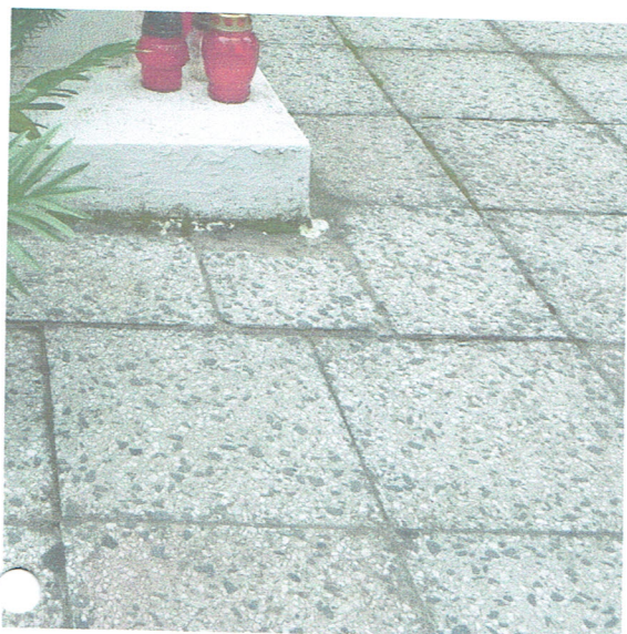
Płytki lastryco na powierzchni poziomej.
