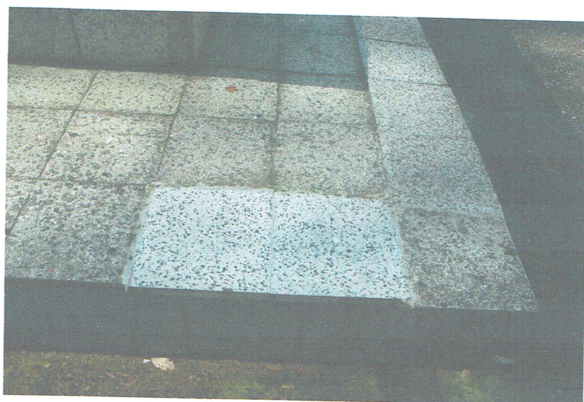
Widoczne uzupełnienia z płytek lastrykowych
