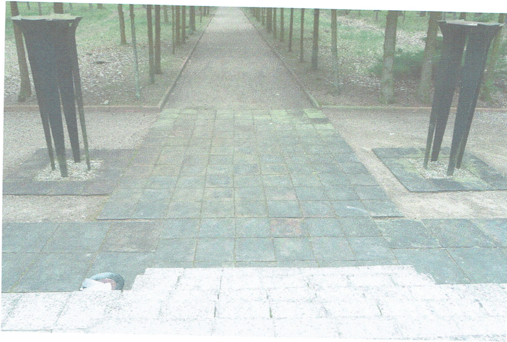
Dojście i obudowa zniczy z płyt piaskowca 35 x 35
