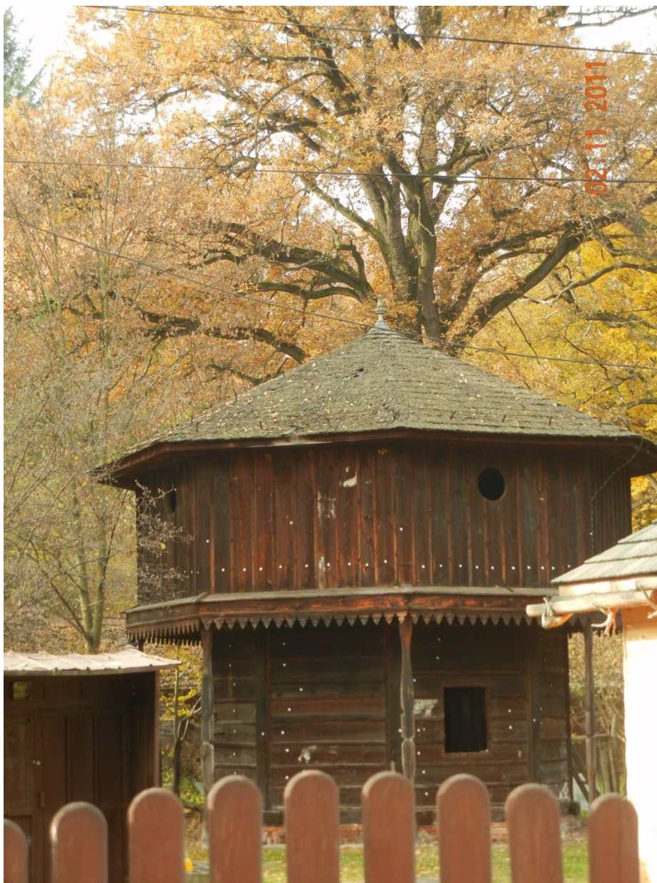
Zespół Budynków Dyrekcji Lasów Ordynacji Łańcuckiej – Dyrekcja Lasów – SUSZARNIA NASION
