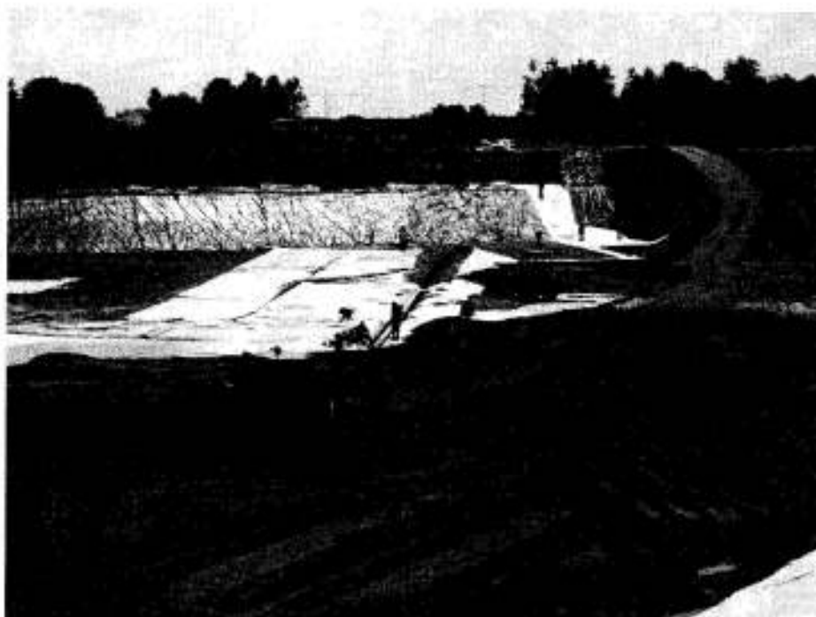
Fot. nr 4. Składowisko odpadów w Kozodrzy
