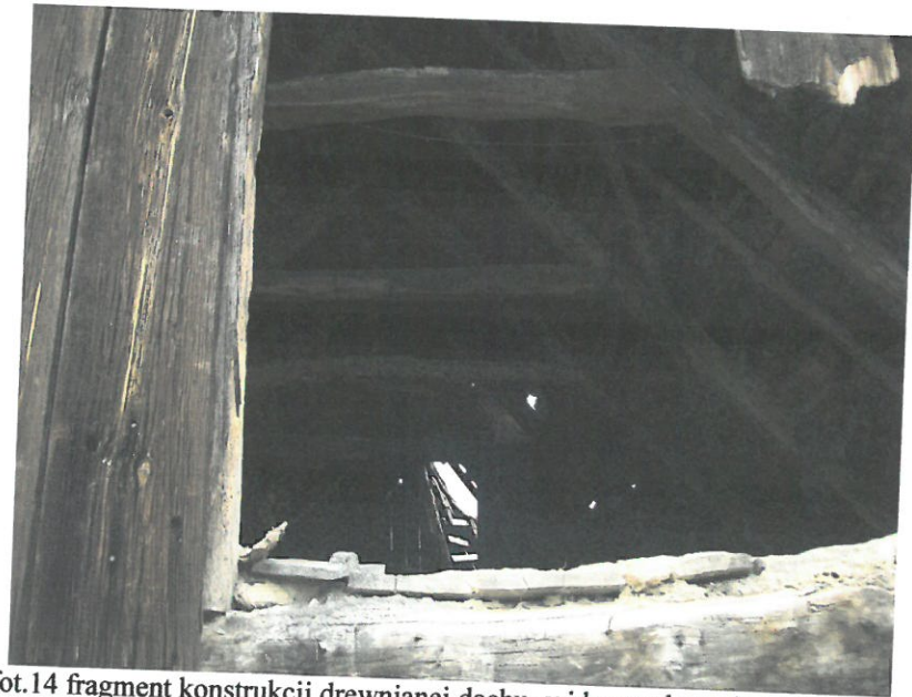
fot. nr 13 fragment pomieszczenia w budynku- widoczna dziura w ścianie wew. i gruz
