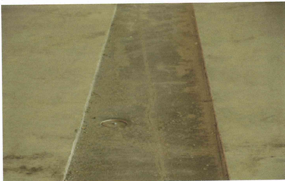
Rys.5 Kanał odprowadzający z odpływem.
