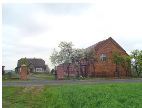
Fotografia. 6. Budynki zagrodowe – na północny wschód
