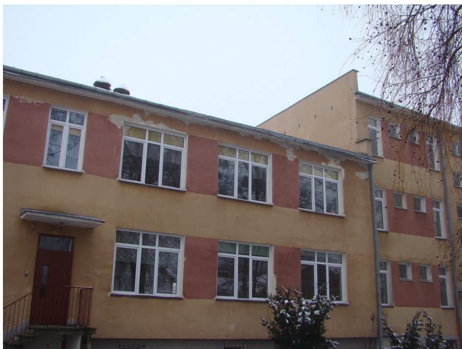
Fot. 10. Widok południowej ściany średniego budynku.
