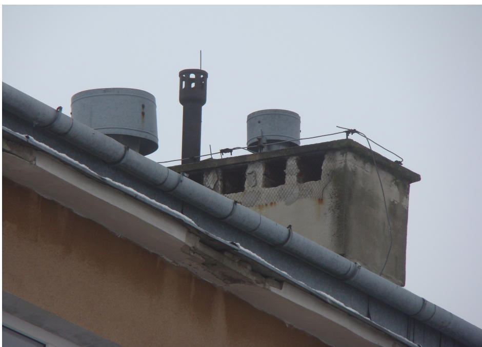
Fot. 5. Widok komina z zabezpieczonymi otworami wentylacyjnymi.
