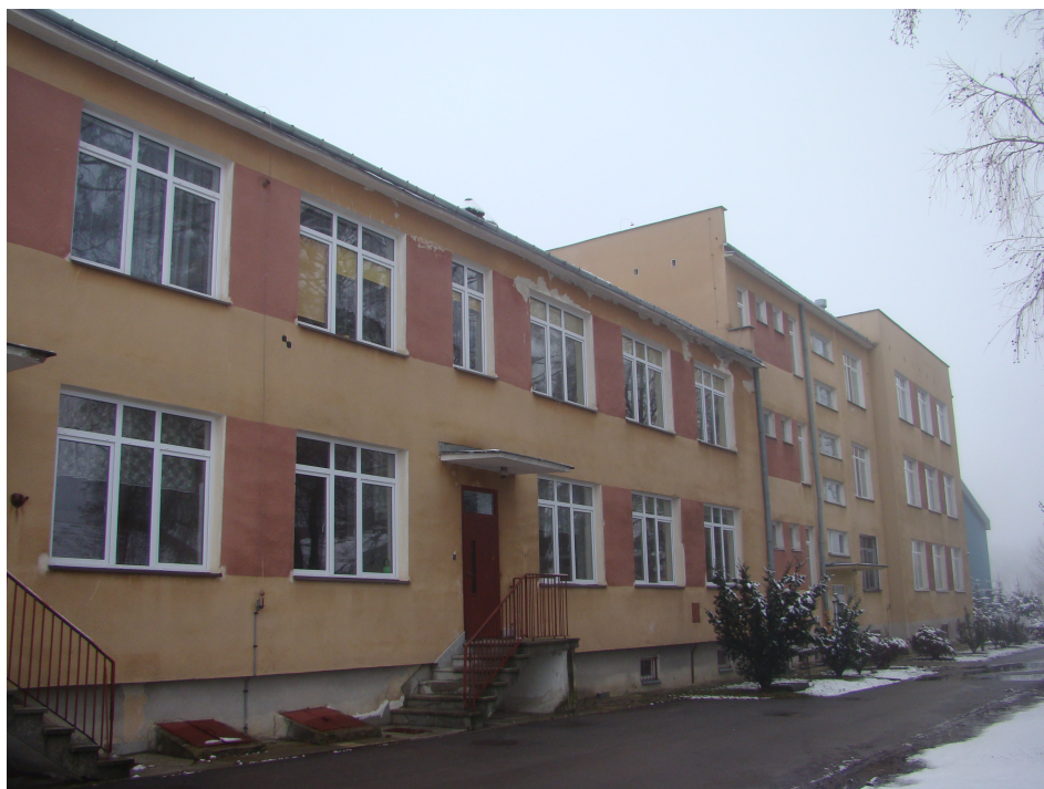
Fot. 16. Wschodnia ściana budynku małego.
