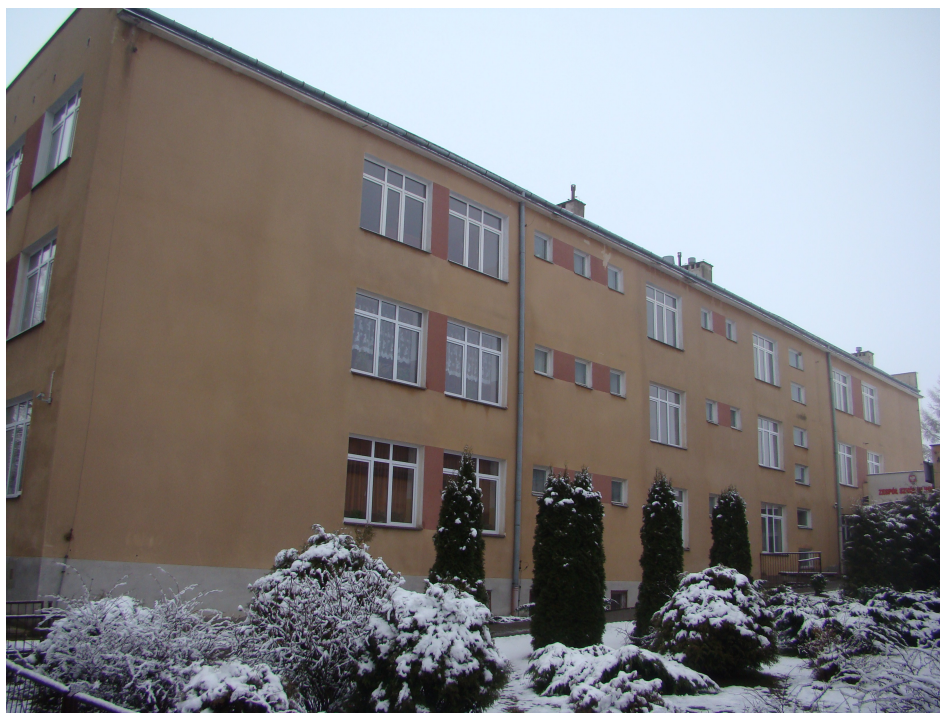
Fot. 6. Widok północnej ściany najwyższego budynku Zespołu Szkół.
