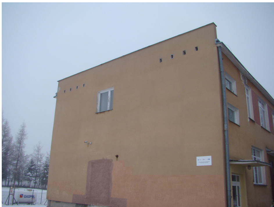
Fot. 17. Ściana południowa budynku małego.
