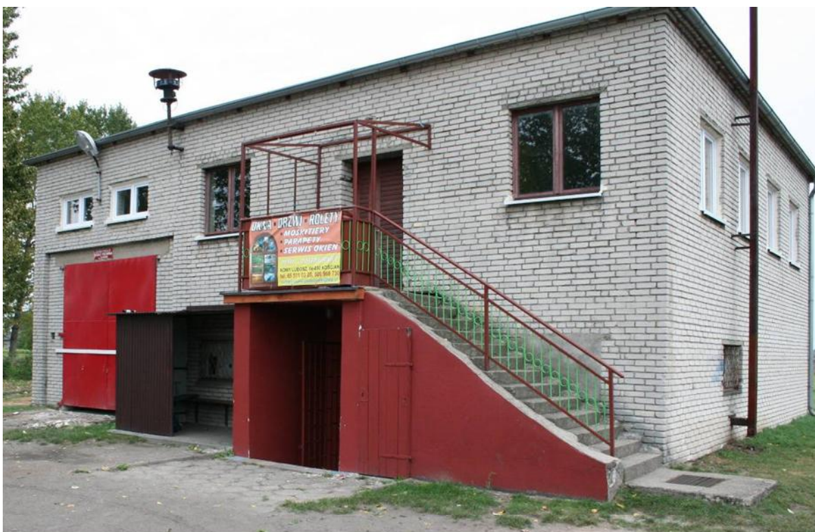
fot. 1. widok schodów przeznaczonych do rozbiórki
