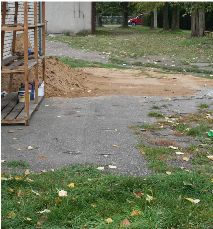
fot.2. widok placu do likwidacji
