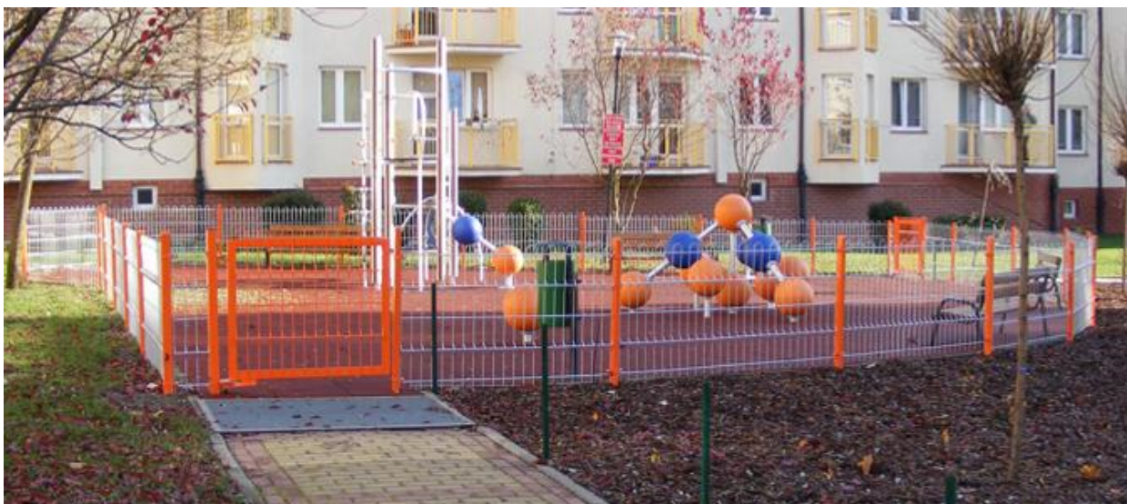
Zdj.08. Przykładowe ogrodzenie placu zabaw
