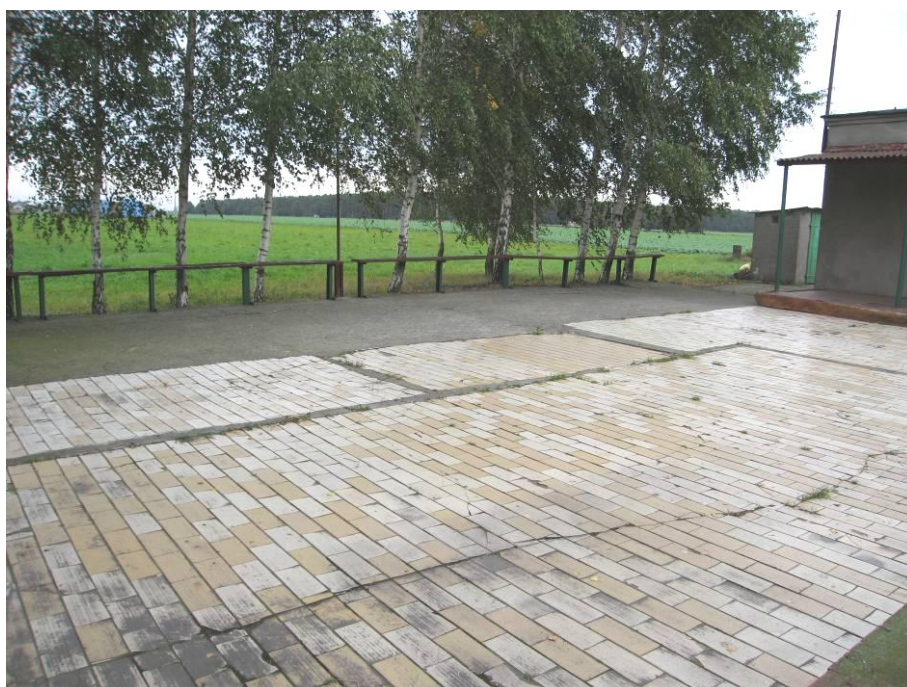
fot.3. Plac widok pokrycia
