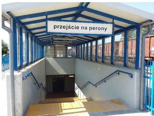
Rysunek 13. Czempiński Węzeł przesiadkowy przejście podziemne
